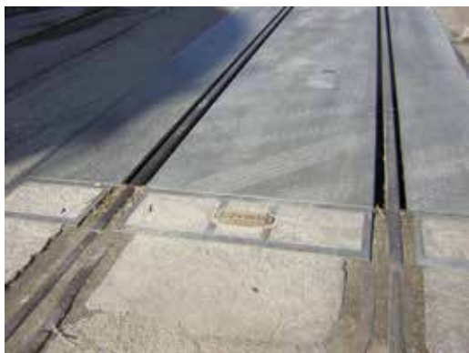
Pesa a ponte doppio uso per vagoni e automezzi
